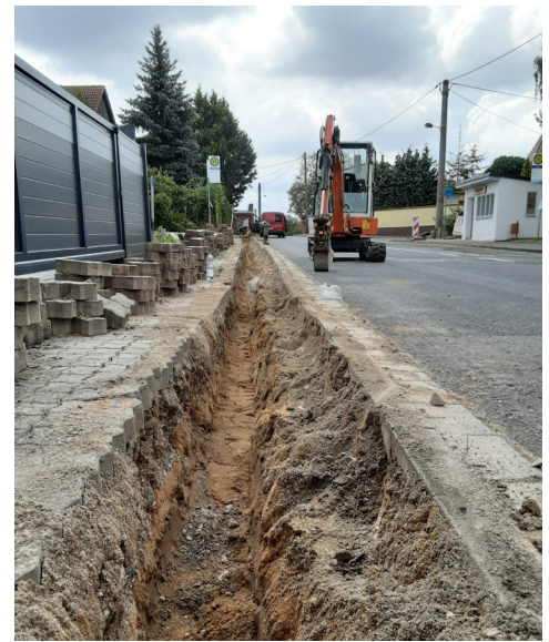
Bauarbeiten zum Glasfaserausbau der Telekom in Schönwölkau OT Badrina.
