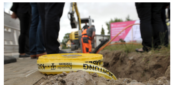
Die Baumaßnahmen in Cavertitz OT Lampertswalde sind bereits abgeschlossen.
